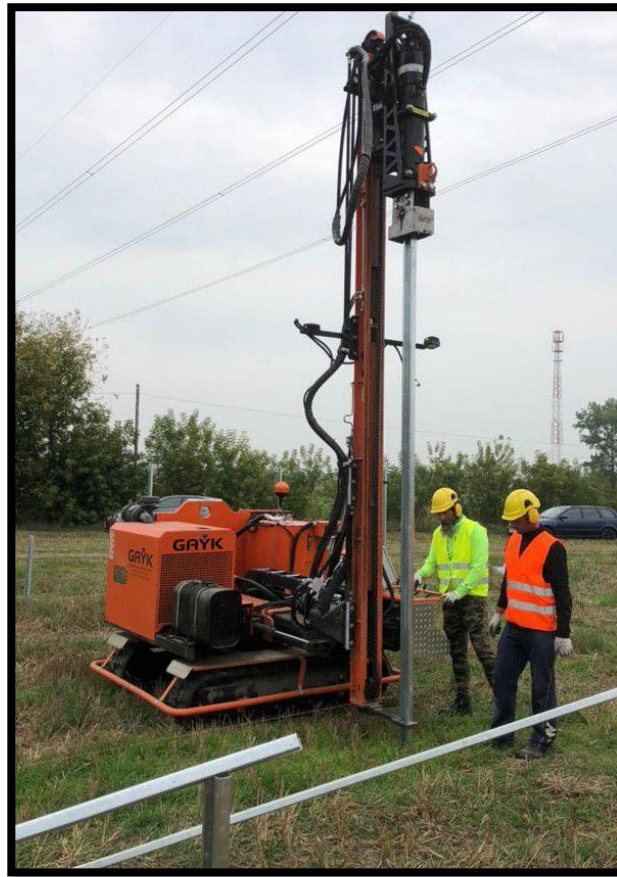
Zdjęcie 4 Montaż konstrukcji wsporczej (kafar)
