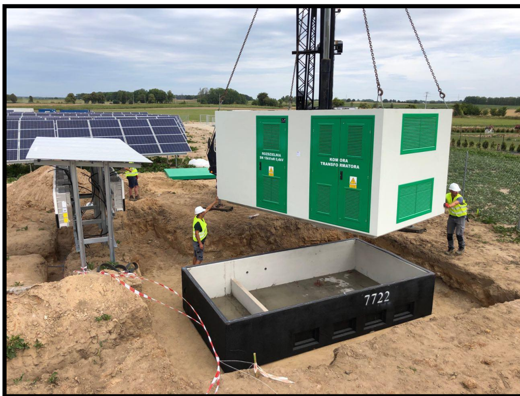
Zdjęcie 5 Posadowienie stacji transformatorowej
