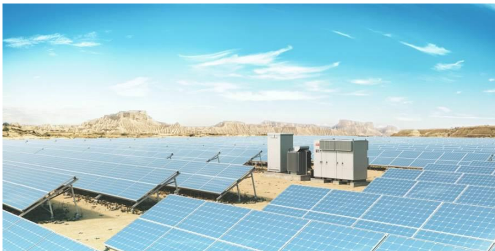
Rys. 17. Inwerter centralny na przykładowej farmie fotowoltaicznej
